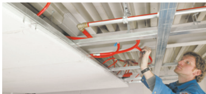
Stropné chladenie v suchej konštrukcii počas montáže
