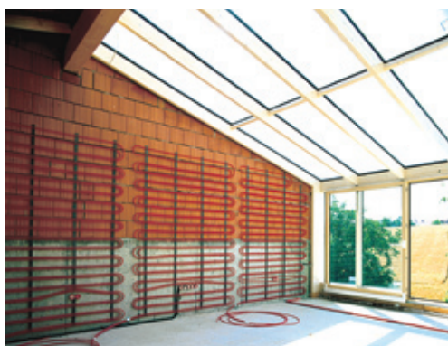
Stenové vykurovanie pri inštalácii
