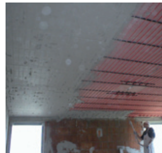
Stropné chladenie v mokrej konštrukcii počas montáže a omietania
