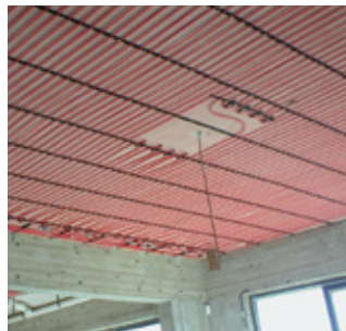
Stropné chladenie v mokrej konštrukcii počas montáže a omietania
