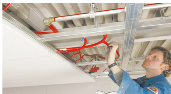
Stropné chladenie v suchej konštrukcii počas montáže
