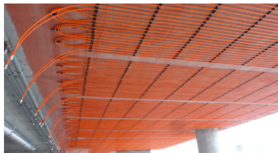
Stropné chladenie v mokrej konštrukcii počas montáže
