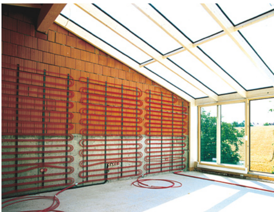
Stenové vykurovanie pri inštalácii
