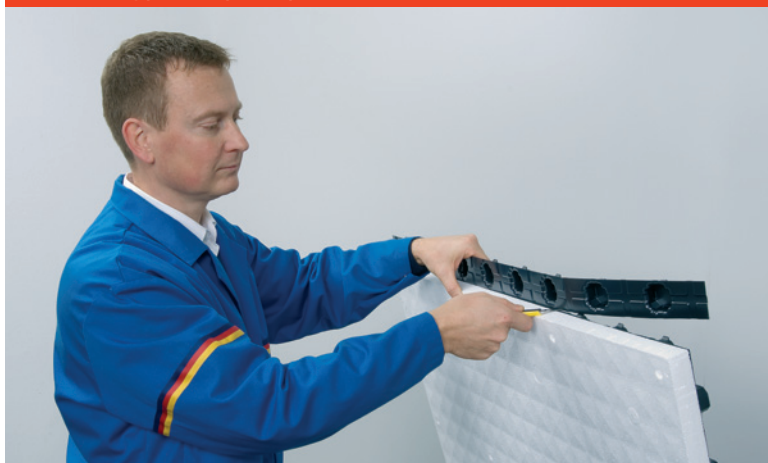
Obr. 3: Fóliový presah nopového prvku treba odrezat'
