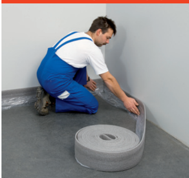
Obr. 14: Pokládka okrajových izolačných pásov
