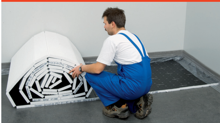
Obr. 15: Pokládka spojovacieho materiálu
