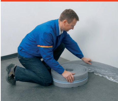
Obr. 2: Pokládka okrajového izolačného pásu
