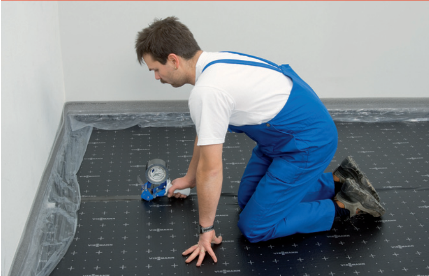
Obr. 16: Prekrytie lepiacou páskou
