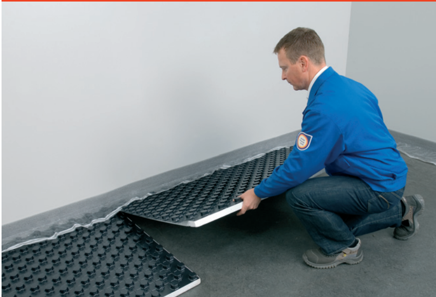
Obr. 5: Spojenie nopových prvkov
