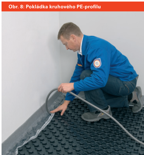
Obr. 8: Pokládka kruhového PE-profilu
