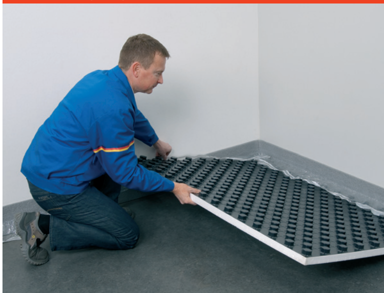
Obr. 4: Pokládka nopového prvku
