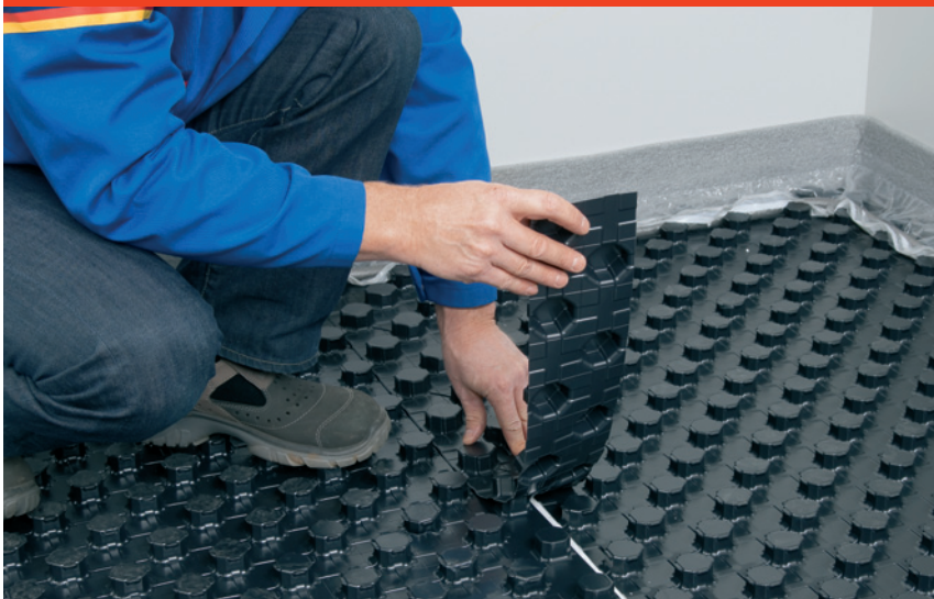
Obr. 6: Nopový prvok narežte „na mieru“
